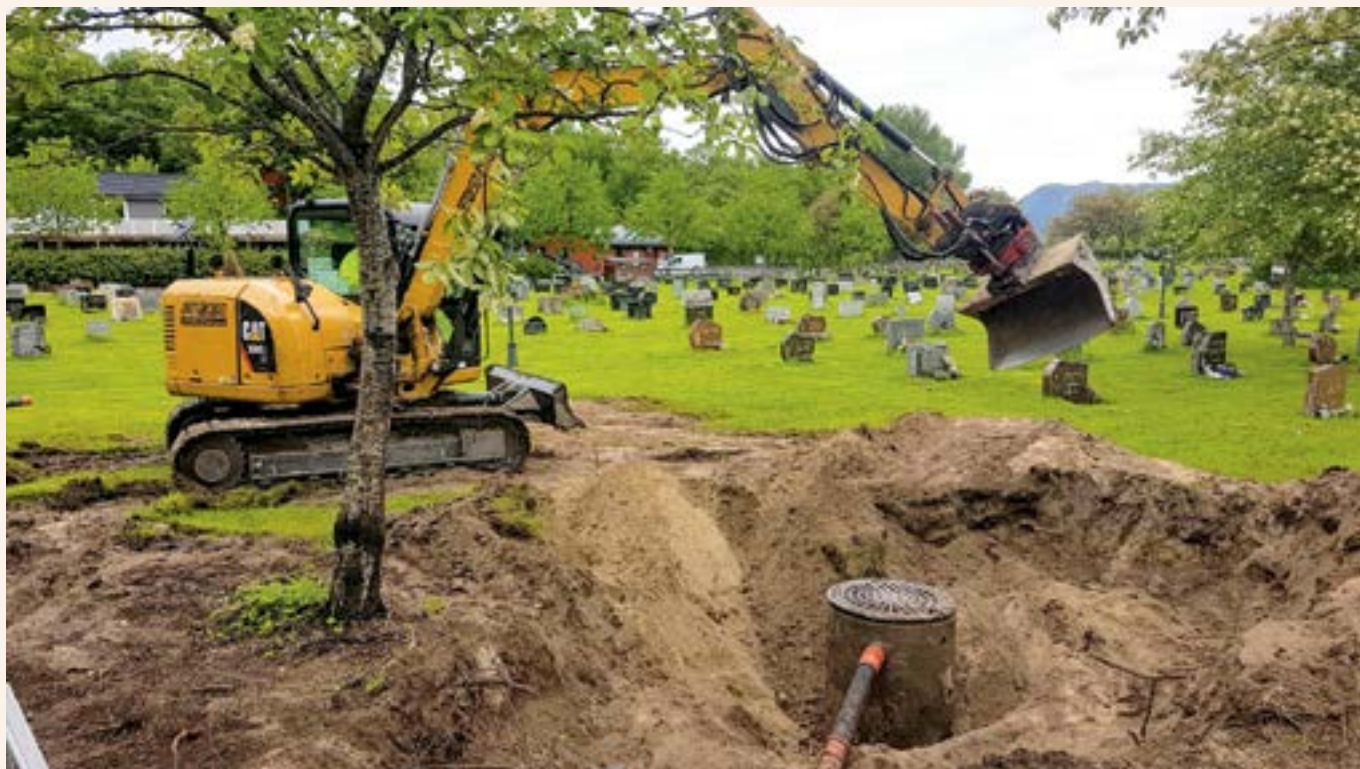
Bendiksen AS i full gang med å montere kumme.
