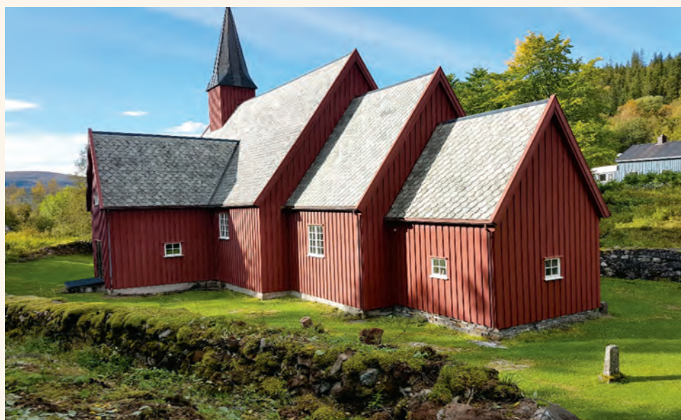
Etter felling av trær. Nøstvik kirke i hele sin prakt etter at trærne er tatt bort.
