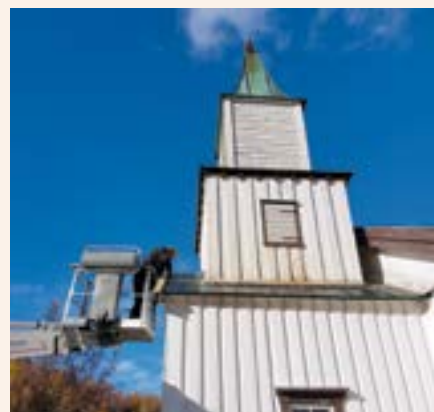
...og her reparer han lekkasje på taket på Lande kapell.
